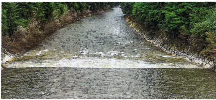
Heute fliesst die Emme im Emmenschachen in einem engen Korsett. Neu wird ein ungesichertes, mit Baumbuhnen strukturiertes Ufer angelegt. Dadurch kann die Emme ihr Ufer selber gestalten.
