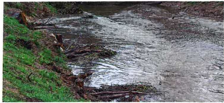
Heute fliesst die Emme im Emmenschachen in einem engen Korsett. Neu wird ein ungesichertes, mit Baumbuhnen strukturiertes Ufer angelegt. Dadurch kann die Emme ihr Ufer selber gestalten.
